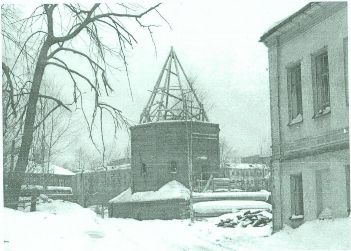
Северо-западная башня ограды Успенского монастыря в г. Кирове. Общий вид строящейся башни с территории монастыря, с юго-востока. Февраль 1989 года, Талантов Г.Б., КСНРПМ
