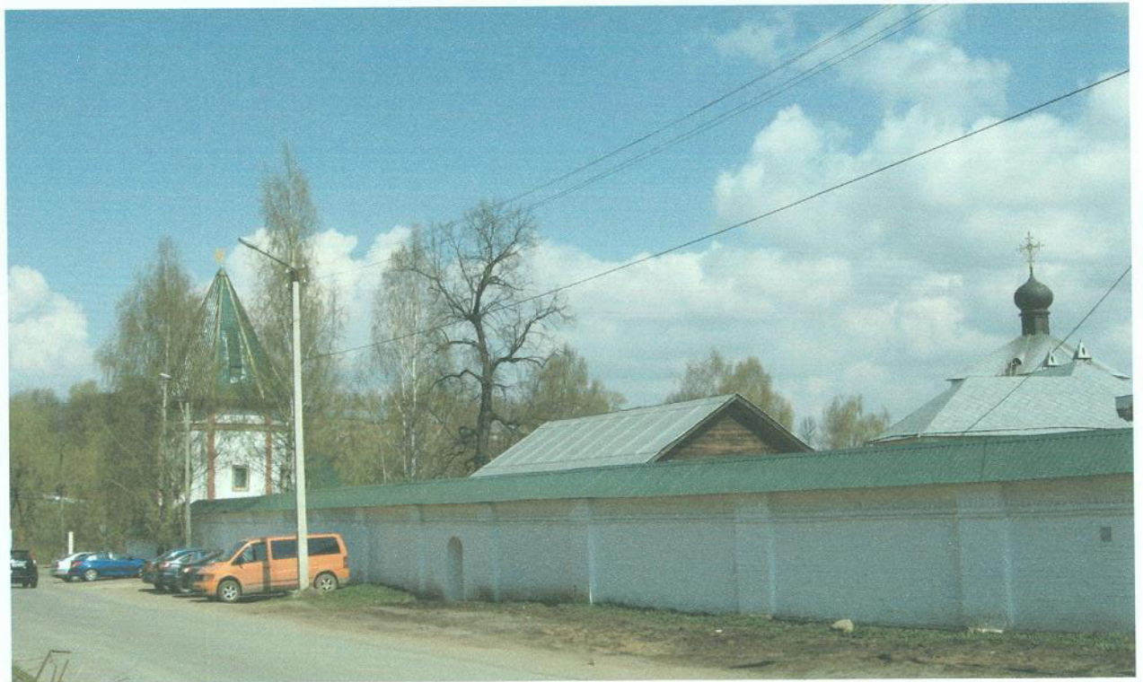
Фото 2. Общий вид с улицы Урицкого, с юго-запада.
