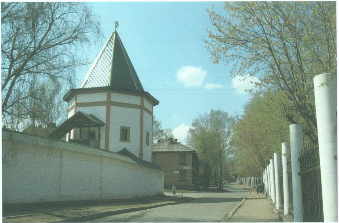
Фото 3. Общий вид в застройке улицы Горбачева, с северо-востока.
