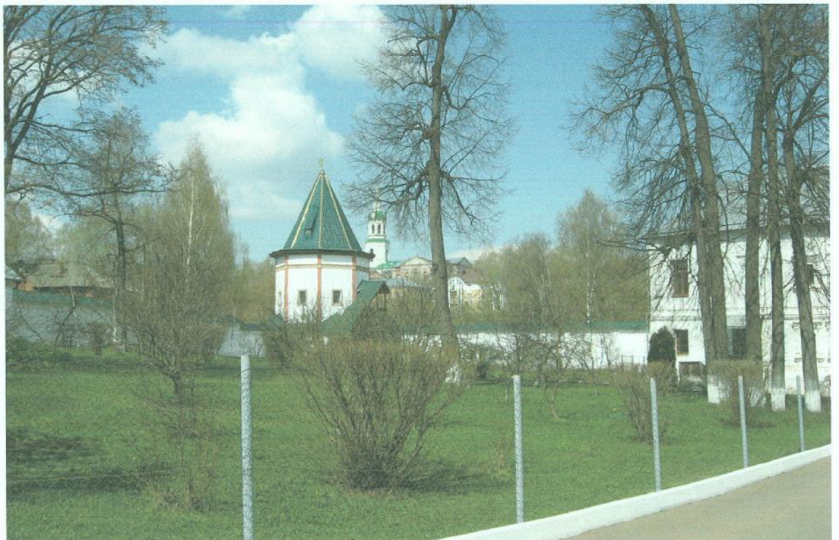
Фото 4. Общий вид с территории монастыря, с юго-востока.
