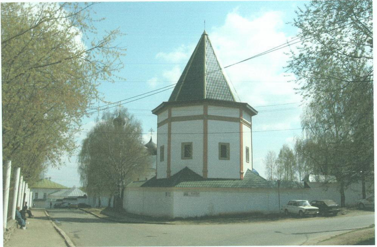
Фото 1. Общий вид с перекрестка улиц Горбачева и Урицкого, с северо-запада.
